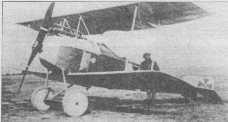
«Авиатик Берг D.I» № 30.14 с двигателем «Австро-Даймлер» мощностью 138 кВт.
