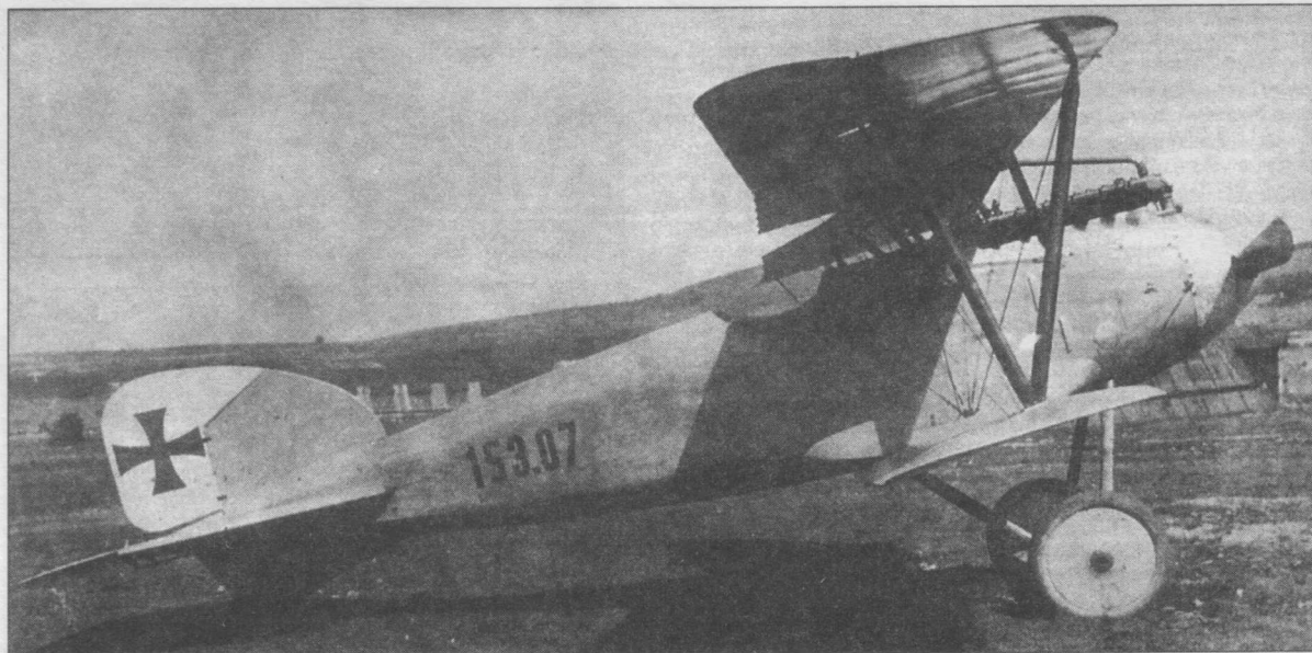
«Оффга Д.III» № 153.07 с двигателем «Австро-Даймлер» мощностью 104 кВт.
